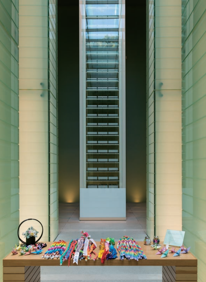
死没者名簿に祈りを捧げる。名簿棚は高さ9m。透明度の高い1枚物のガラスが4面に入っている。構造的には名簿棚もガラス柱も天井の鉄骨梁から吊り下げる方式がとられている。
