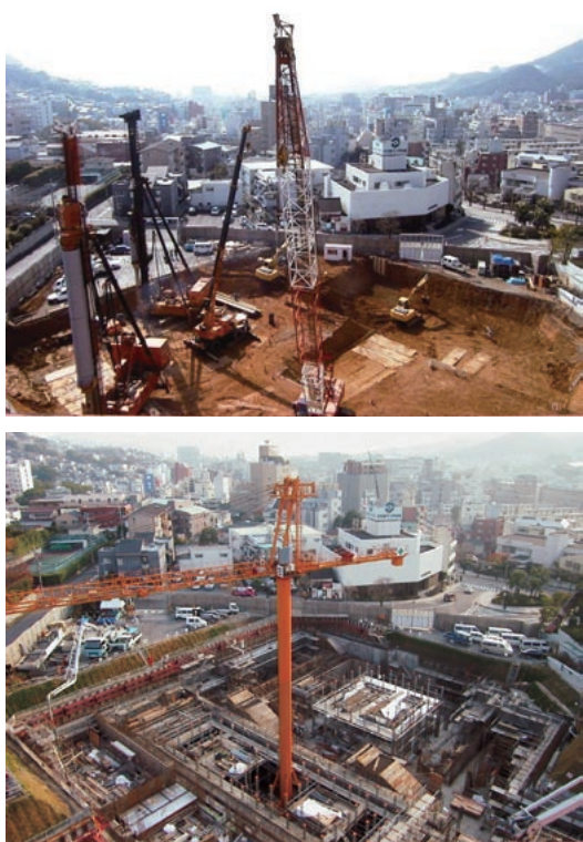
上/掘削中の現場。2方向に建物が迫り、地下建物の軸が45度振れているため、搬出入動線が限られた。 下/掘削後、躯体工事の進行。追悼空間部分にタワークレーンを設置し、建築資材を運搬した。(提供：(株)大林組)
