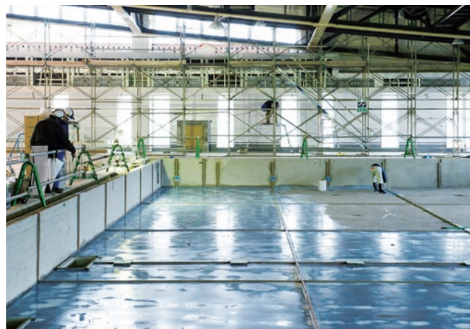
左／プール用タイルをはるタイル工事の様子。不陸の誤差は、2.5mm以内で施工される。右／健康増進プールの床モルタルを増し打ちする様子。
