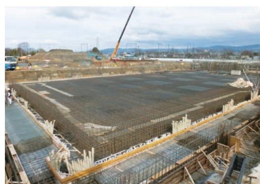
上／屋外プール下に施工されている杭の様子。最大で1,000φの杭も使用された。 下／プールの耐圧版を施工した様子。（提供：（株）奥村組）
