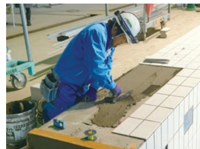
左／プール用タイルをはるタイル工事の様子。不陸の誤差は、2.5mm以内で施工される。右／健康増進プールの床モルタルを増し打ちする様子。
