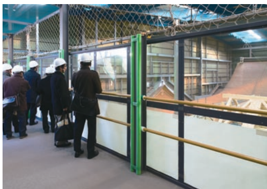
素屋根内における見学専用通路の様子。工事の進捗状況に合わせて、通路の架け替えも行われている。
