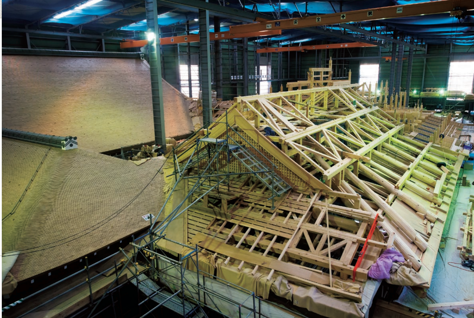
雨風の影響を受けないよう素屋根で覆われた空間内で、対面所等の工事が行われている。左手の建物はすでに公開されている表書院で、工事中の建物との境界がはっきりとわかる。
