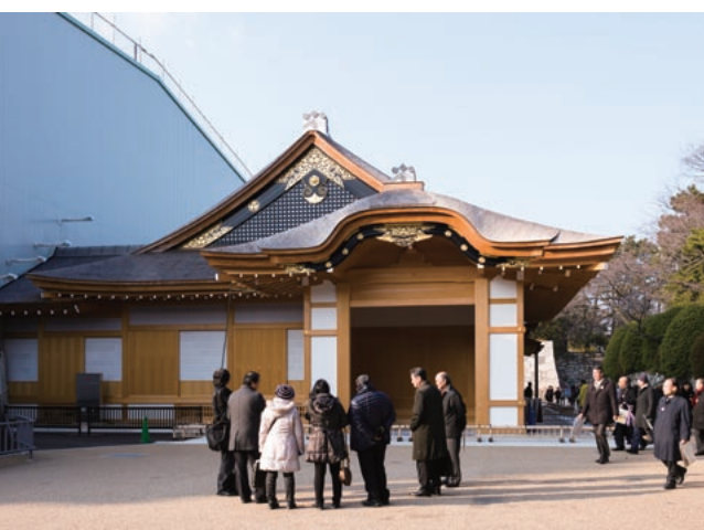
上／礎石の下には、戦災で焼け残った本来の礎石が遺構として残されている。遺構の保護として、山砂が手作業で敷き詰められ、その上にコンクリートが打設されている。 下／第一期工事で完成した玄関・車寄の様子。その左側には、工事が行われている素屋根も見え。工事中にもかかわらず一般見学者は多い。
