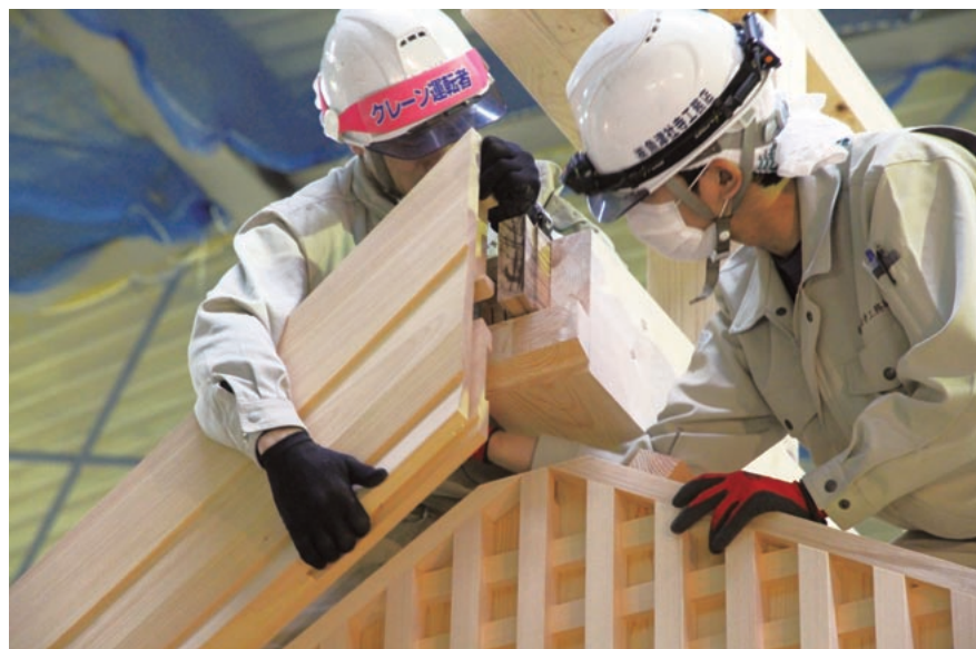
上／木材加工場の様子。すべての作業は一般見学者から見えるようになっている。 右／現場では、屋根の破風板の取付が進められていた。職人が手作業で建物の骨格を組み上げる。(提供：名古屋市民経済局名古屋城総合事務所)
