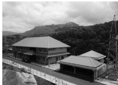
スイッチヤード管理棟
