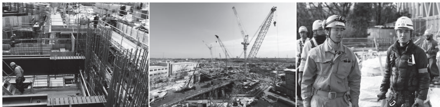
左/現場は鉄骨造と鉄筋コンクリート造の混構造。鉄骨建方の仕事は少ないが、複雑に入り組んだ現場内の足場を組むなど鳶工の持ち場は多い。 中/広い現場の中央付近にタワークレーンが立つ。タワークレーンの設置・解体も鳶工の役目だ。 右/大林組・坂田主任と荻野。「段取り・手配は私たちゼネコンがしますが、最前線で働いているのは職人さん。彼らの仕事の流れから学ぶ部分は多いです」
