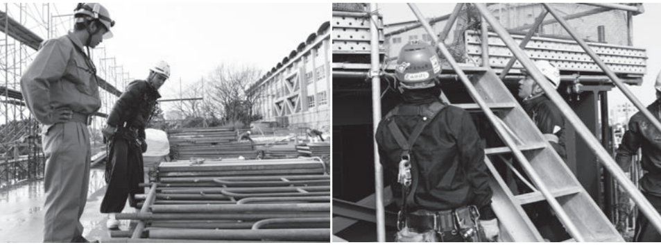
左／工程を決めるのはゼネコンだが、その中の細かい手順・重機のやりくり・資材の搬入スケジュールなどは鳶工に一任される。当然、現場での確認も重要だ。 右／足場の上るための階段の設置。他職も含めすべての作業員が安全に効率よく働くための環境・職場づくりを一手に引き受ける。
