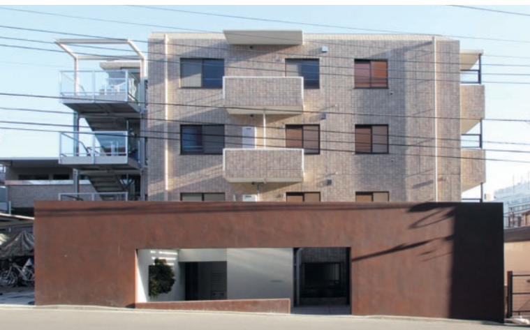
劣化状況を細部にわたって精査し、大規模修繕。外観デザインも一新する。
