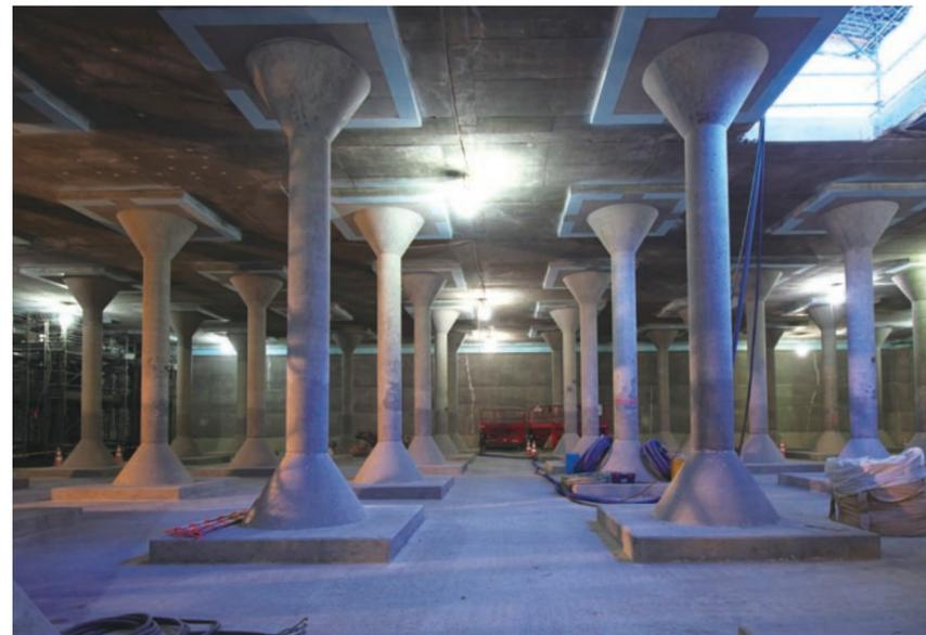
地下配水池の内部には5mピッチで224本の支柱が整然と並んでいる。直径50cmのこの円柱はコンクリートを15cm打ち増しし80cm角の角柱になる。天井部には資機材の搬入、粉塵の放散を目的に8カ所の開口部が設けられている。
