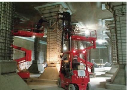
上／出番を待つ鋼製型枠。通常の木製型枠は使用後に廃棄物として撤去されるが、鋼製は転用が利く。環境にも優しい工法だ。
