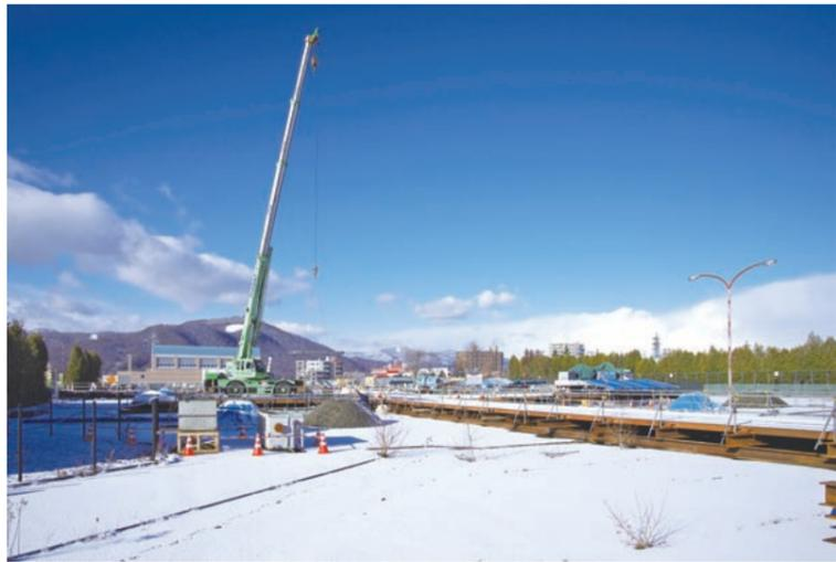
取材翌朝に再訪した際は晴天。ポンプ車やクレーンを支える覆工板は雪に隠れて見えないが、耐荷重1㎡あたり3tの作業エリアを厳守している。隣接する稼働中の池の施設を破損しないよう慎重に施工する。
