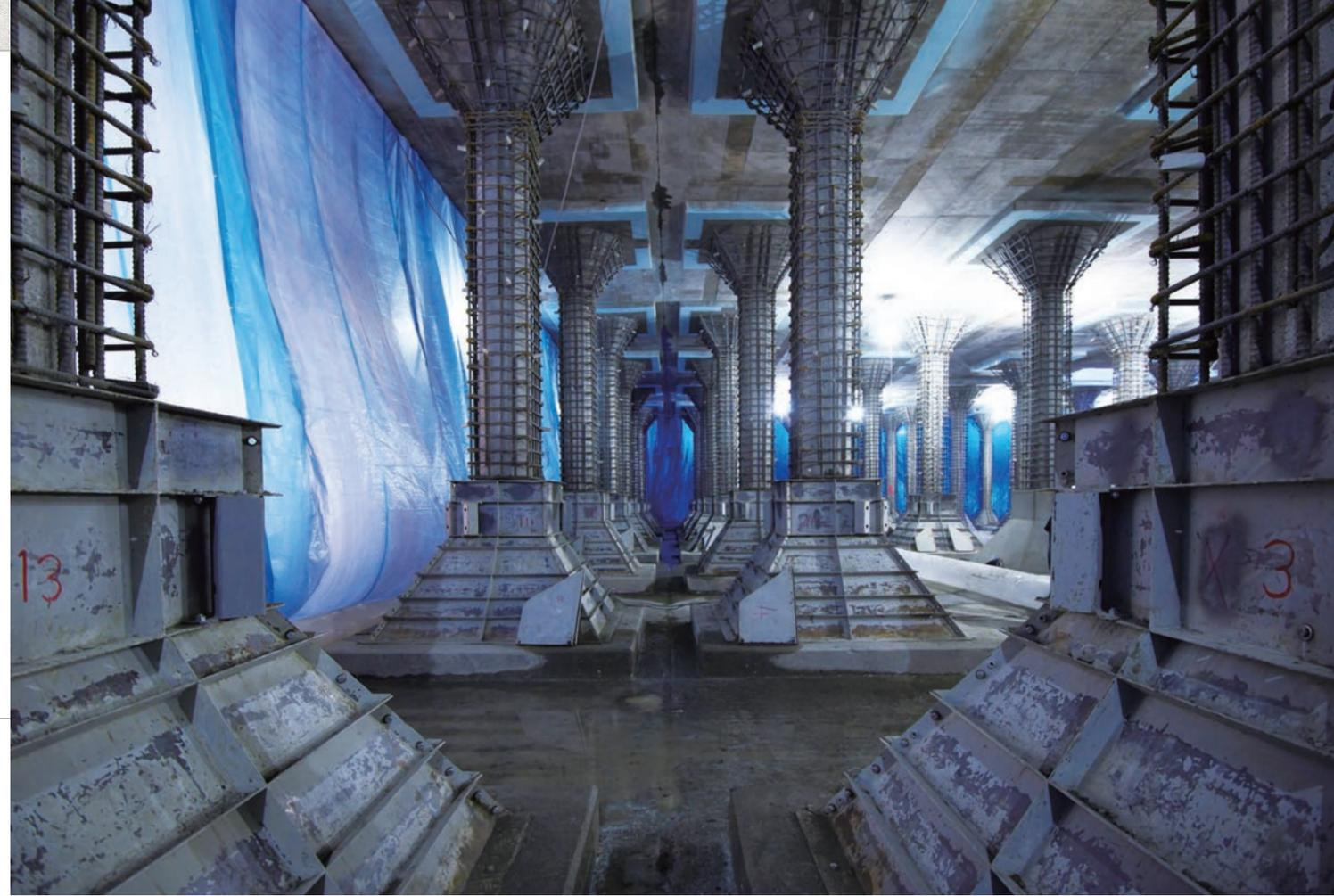
地下神殿の様相を見せる平岸配水池の内部。ここで札幌市内に供給する上水を蓄えていた。上部工を支える円柱を補強し、地震に強い水道インフラの要を再整備する。既設の円柱が鉄筋と型枠をまといコンクリートの打設を待っている。
