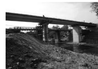
Ea Soup 橋 上部工施工状況
