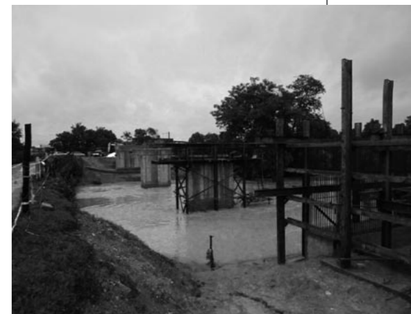
Ea Soup 橋 下部工施工状況
