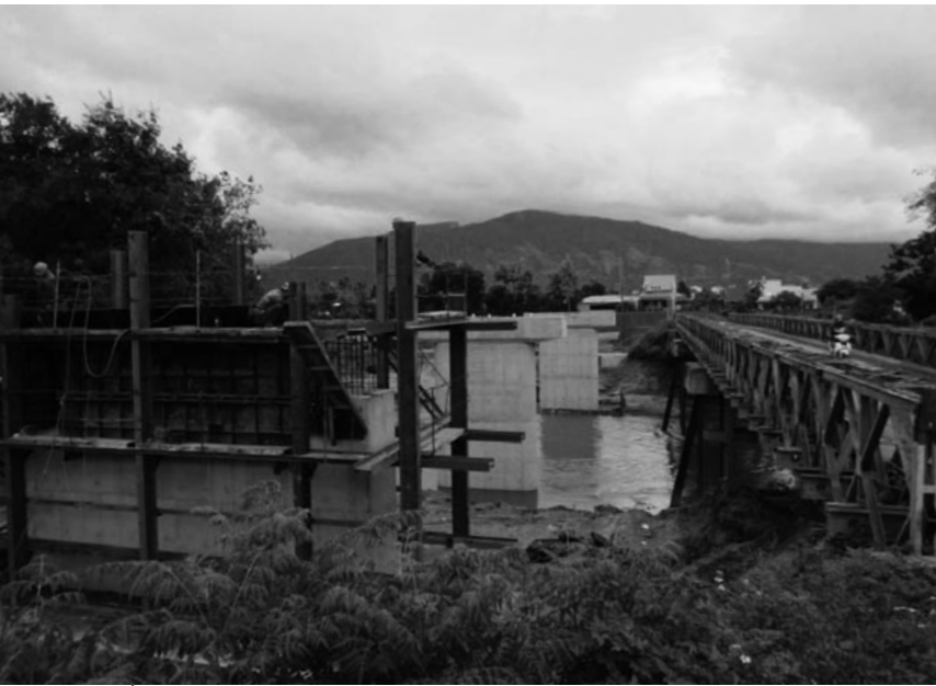
Krong Kmar 橋 下部工施工状況
