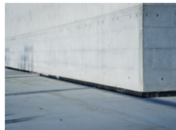
上／ケーソン底部には摩擦力を増大させるアスファルトマットが施工されている。左／海洋構造物であるケーソンにおいて、鉄筋の腐食は大敵だ。腐食を防ぐために鉄筋組立時には鉄筋防錆剤を全面塗布し、さらに亜鉛メッキ結束線で全結束する。
