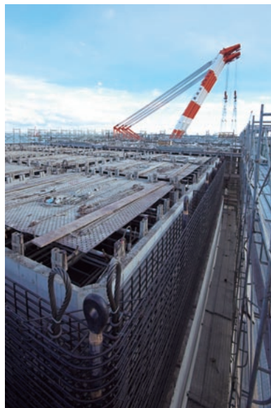
上／ケーソン底部には摩擦力を増大させるアスファルトマットが施工されている。左／海洋構造物であるケーソンにおいて、鉄筋の腐食は大敵だ。腐食を防ぐために鉄筋組立時には鉄筋防錆剤を全面塗布し、さらに亜鉛メッキ結束線で全結束する。
