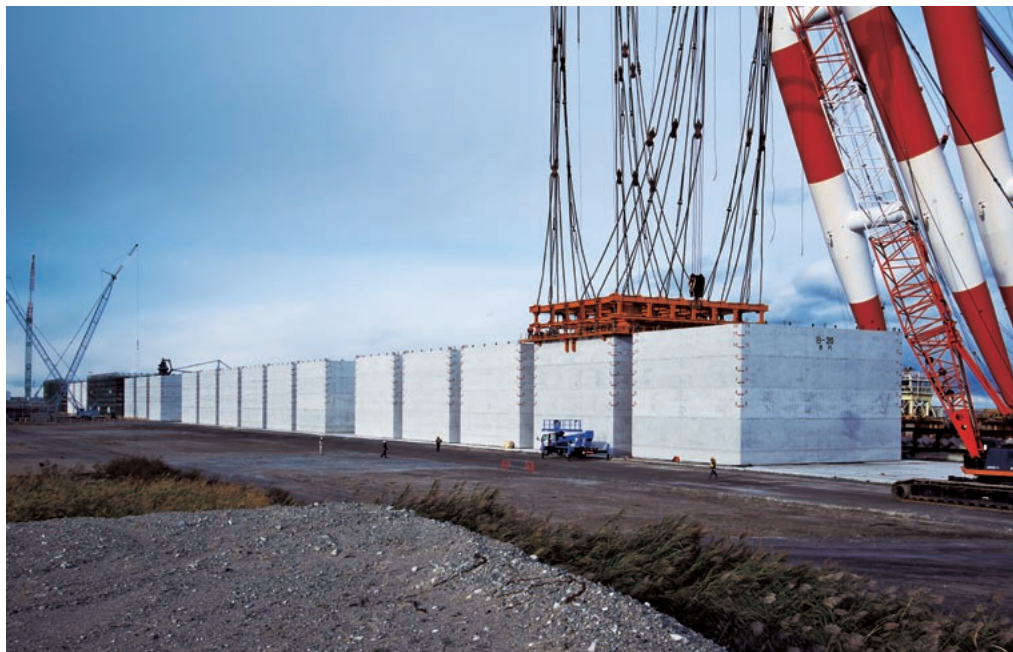
20函以上のケーソンが整然と並んでいた。これだけの数が一度に製作された例はかつてないだろう。ケーソンの吊り降ろしに国内最大級の起重機船が稼動する風景は圧巻だ。
