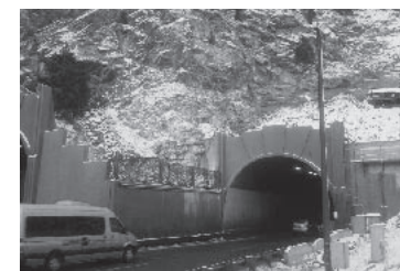
I-70トンネル拡幅前
