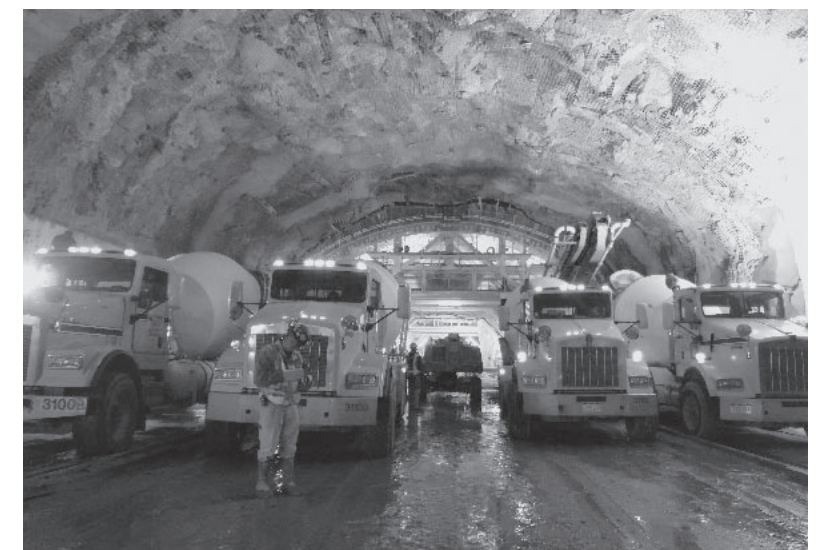
覆工コンクリート打設状況
