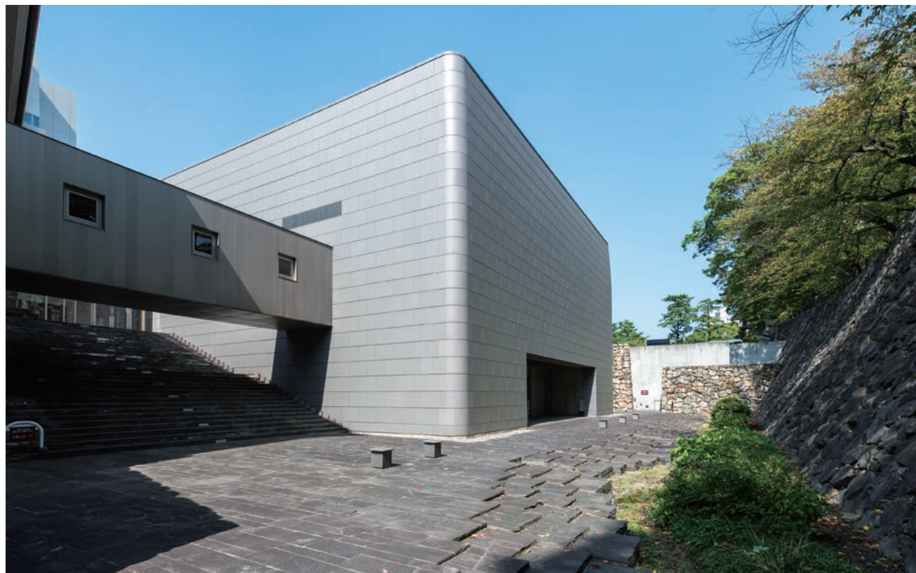
中央棟の外装は陶板。地下階の濠のレベルに鉄平石を敷いてテラスや植え込みがづくり込まれた。 宮本忠長氏が石垣の上から全体を眺めながら鉄平石の配置を調節していった。魅力的な空間が多くの人を惹きつけている。
