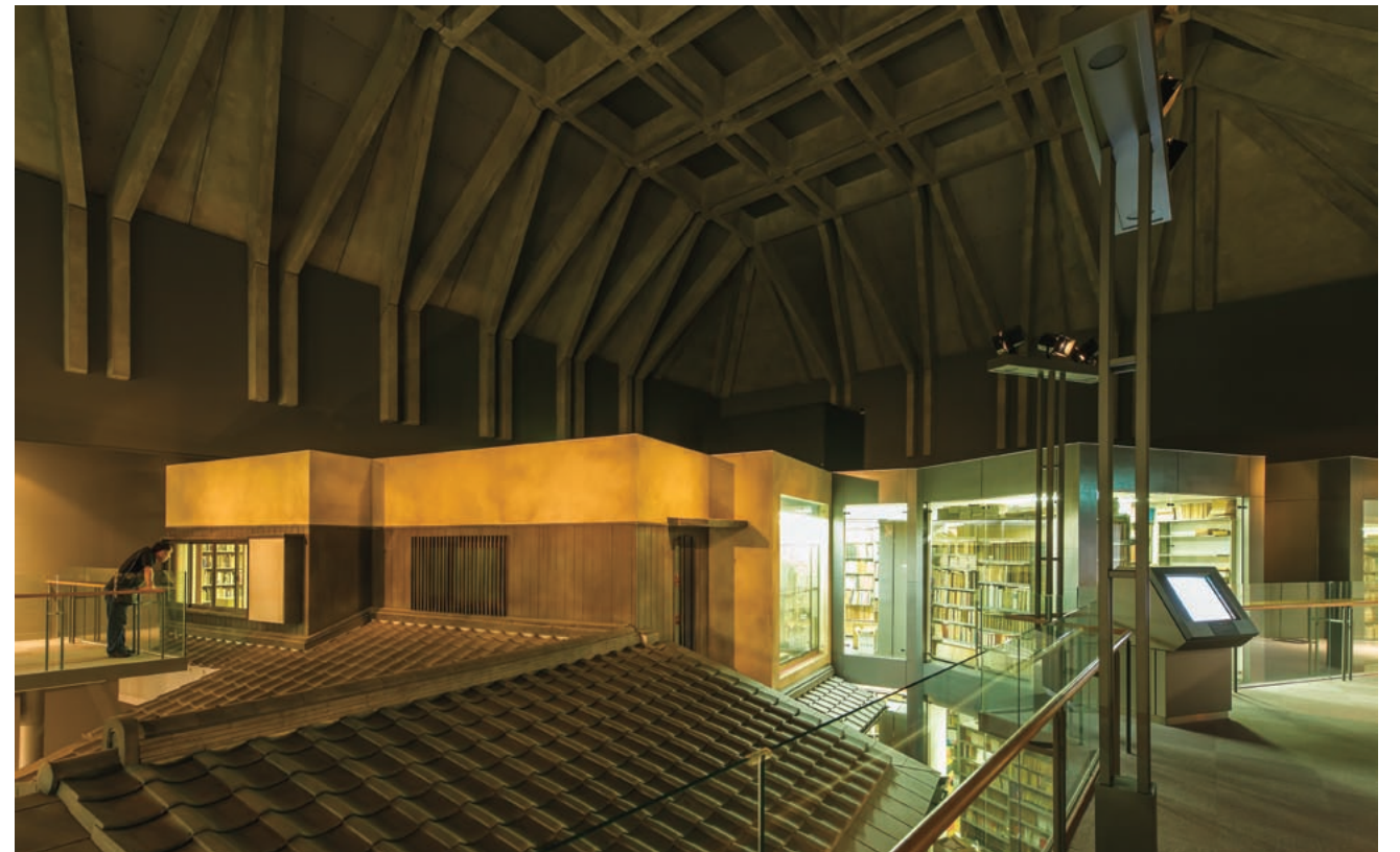
常設展示室2「思索と創作の城」。2階のデッキから松本邸の書斎、書庫を窺うことができる。蔵書の並び方ももとのまま。屋根は格子とY形に成型したプレキャストコンクリート版を構造体とし、ドーム状の大空間を可能としている。
