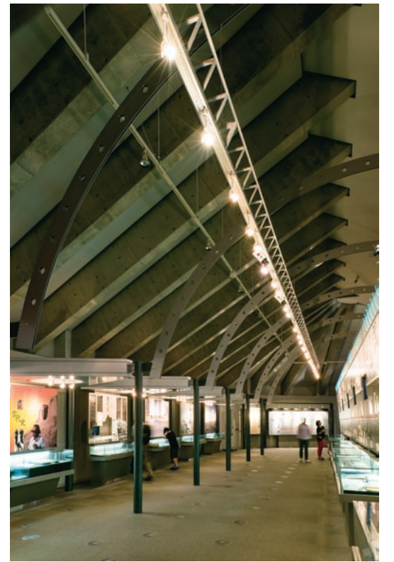
常設展示室1「松本清張の世界」。清張の多岐にわたる創作活動の全貌を紹介している。連続する梁は鉄筋コンクリート打放し。
