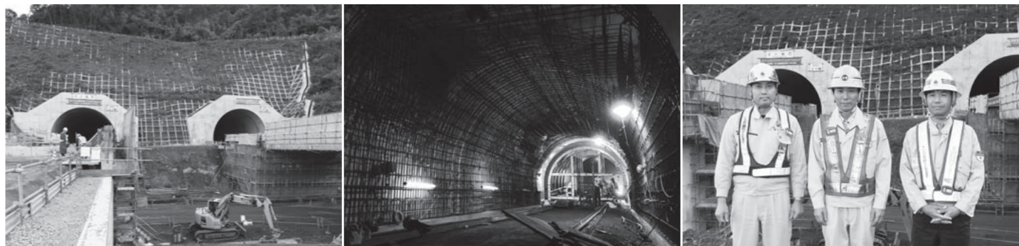
左/相模原市を通るさがみ縦貫道路の葉山島トンネル上下線の坑口。 中/トンネルはすでに貫通完成。現在は上下線や連結トンネルで二次覆工の鉄筋組立等が行われている。 掘削だけでなく、こうした仕上げ工事もトンネル工の作業区分だ。 右/左から、成豊建設・田島作業所長、小田原、大成建設・中原作業所長。「ゼネコンとサブコンの良好な関係を、これからも保っていききたい」と中原作業所長。
