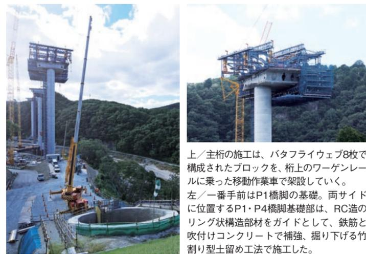
上／主桁の施工は、バタフライウェブ8枚で構成されたブロックを、桁上のワーゲンレールに乗った移動作業車で架設していく。左／一番手前はP1橋脚の基礎。両サイドに位置するP1・P4橋脚基礎部は、RC造のリング状構造部材をガイドとして、鉄筋と吹付けコンクリートで補強、掘り下げる竹割り型土留め工法で施工した。
