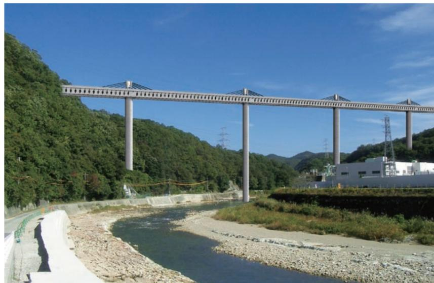
完成後のイメージイラスト。桁側面のバタフライウェブは、本来50mほどの支間長に適した部材だが、武庫川橋は100mにもなるため斜材で強度を確保するエクストラード構造が採用された。(提供：三井住友建設株式会社)
