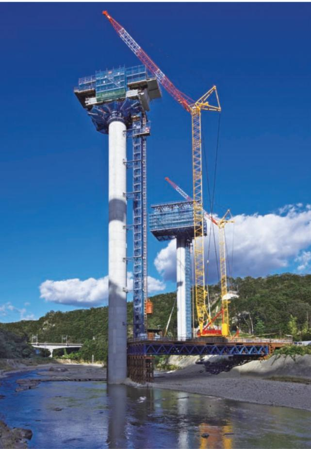
河川内に建つP3橋脚。基礎工のため8mほど積み上げた2000個以上の大型土嚢が川の増水により突破されたこともあった。8台のポンプで排水しながら施工した。
