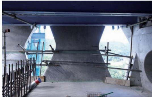
蝶の形をした「バタフライウェブ」。NEXCO西日本との共同開発による鋼繊維配合の高強度コンクリートが本体部分に採用されている。
