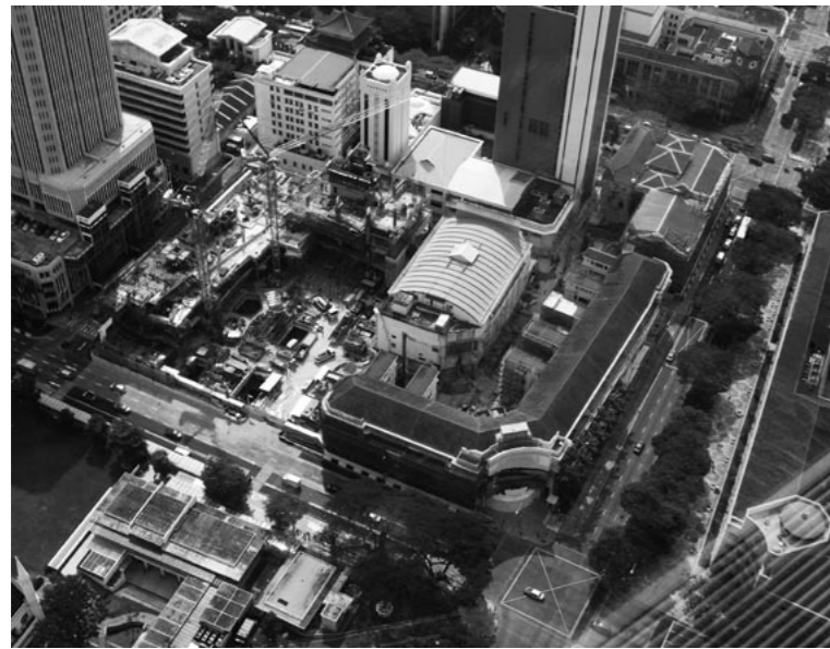
工事現場全景写真(2013年9月)
