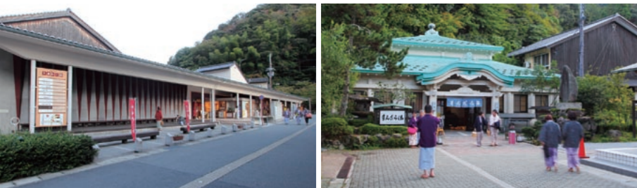
左／街の新しいシンボルとして人気を集める複合施設「木屋町小路」の壁面にも街の防火対策のための「火伏壁」が街路に沿って建つ。右／七軒ある外湯の一つ「まんだら湯」。一の湯とおなじく震災復興時に、鉄筋コンクリートで再建された。
