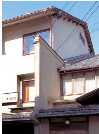
側面に類焼を免れるための防火壁を設けた家屋。震災、大火の記憶を伝える。
