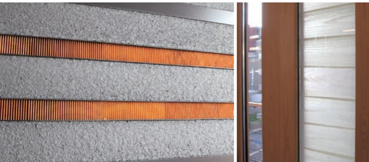
カンナがけした薄い木を挟んだガラス(右)、フィンガージョイント材を木目が見えるように利用した吸音材(左)など、木の美しさを伝える工夫が全館に施されている。
