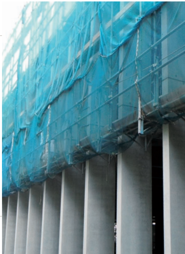
1階から3階まで、縦方向に途切れることの無い一本の柱が整然と並び建物を支える。
