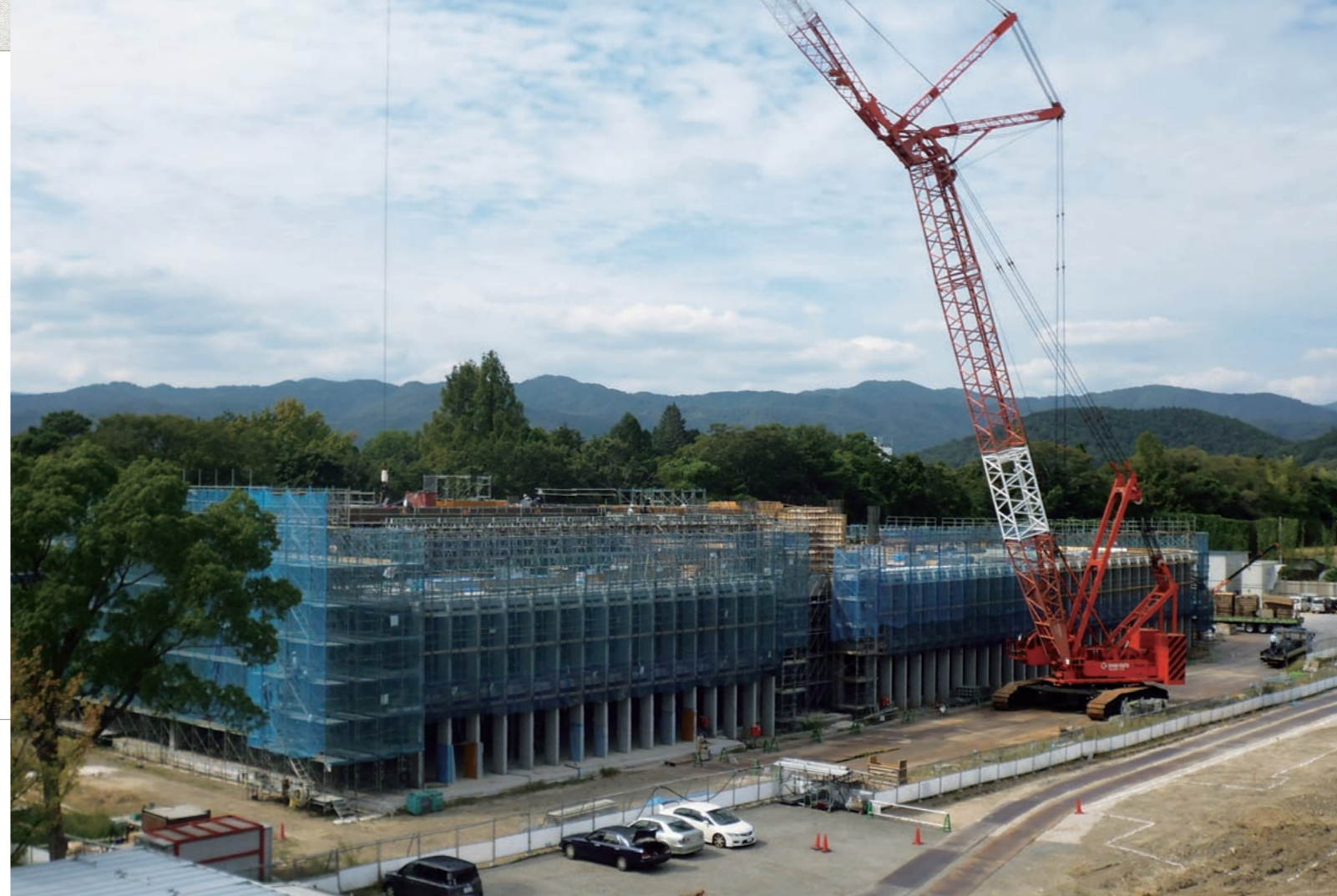
教養教育共同化施設はPCaPC構造とRCのハイブリッド仕様。横に広い正面部分は全体が工場制作されたPCaPC部材による構造だ。ルーバー兼用の細柱と床版の施工が着々と進行中だ。
