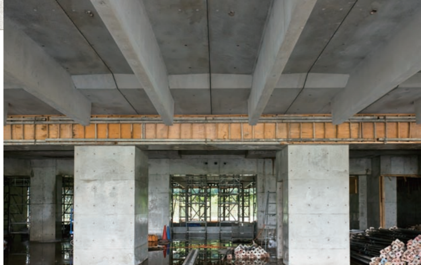
上／室内の天井は照明器具のプレートが配置されるだけで、リブやコンクリートは内装として露出する。美しい仕上げに細心の注意を払った。(撮影：山田新治郎)
