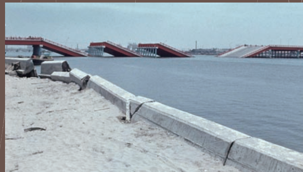
1964（昭和39）年の新潟地震にて落橋した「昭和大橋」（提供：（公社）土木学会附属土木図書館、撮影：倉西茂・高橋龍夫）
