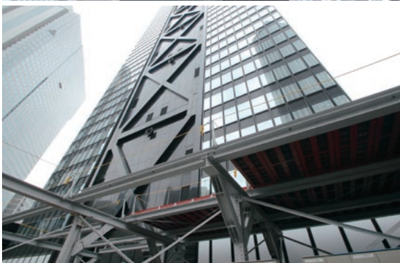
左上／完成予想図。六基のTMDが屋上に載る。(提供：鹿島建設株式会社) 左下／地上部に設けられた構台。ここから屋上に資材が揚げられる。右／新宿三井ビルの屋上。
