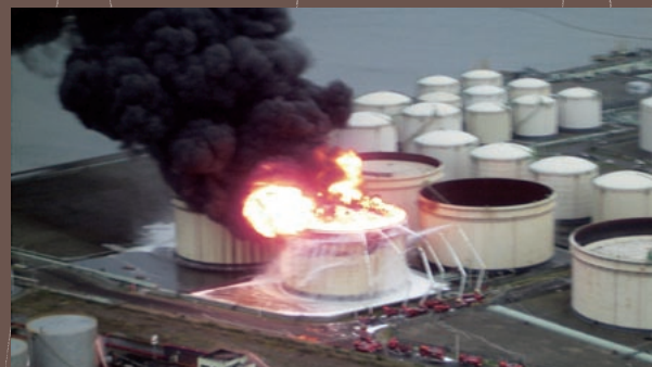
長周期地震動と石油タンクの固有周期が一致し、タンク内の石油が振動。浮き蓋と側壁が擦れて火花を発生し、引火した。（提供：消防庁消防研究センター）
