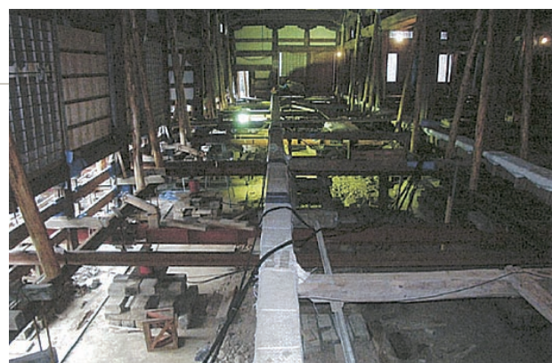
建物を地面から約1m持ち上げた様子。床組みの下には井桁状に鉄骨が組まれており、それをジャッキが支えている。（提供：松井建設株）
