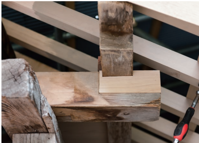
補完された木材の様子。部材の長さを後世へ伝える為に端部を切り落とさずに、新しい木材を補完している。新旧の木目も揃える事で、長い年月をかけて馴染んでいく。
