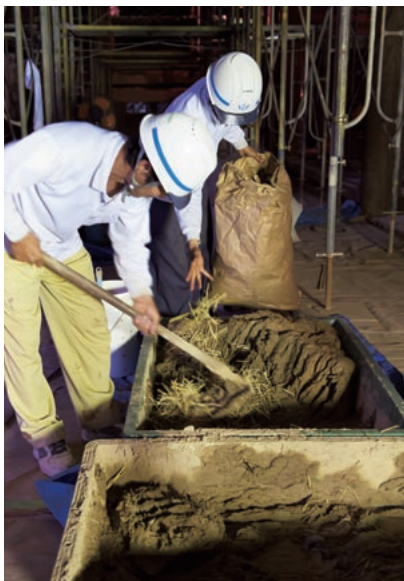
上／土塗り壁の調査写真。5つの段階 を経て壁を仕上げている。左から小 舞、荒壁、斑直し、中塗り、漆喰上塗 りの順。（提供：松井建設株） 左／斑直しに使用される土を練ってい る様子。藁と混ぜた後、使用する。
