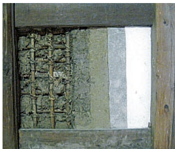
上／土塗り壁の調査写真。5つの段階 を経て壁を仕上げている。左から小 舞、荒壁、斑直し、中塗り、漆喰上塗 りの順。（提供：松井建設株） 左／斑直しに使用される土を練ってい る様子。藁と混ぜた後、使用する。
