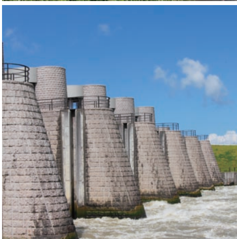
分水路河口部に近い第二床固（上）、急流による川底の洗掘を押さえている。信濃川本川に設 置された洗堰（下）は下流域に安定した水を供給するいわば「心臓弁」だ。
