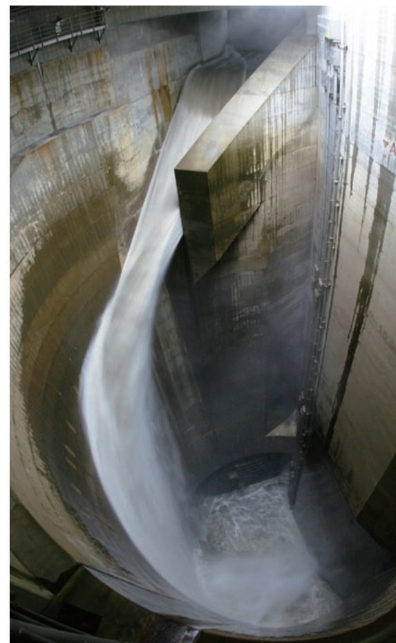
第3立坑の内部。60mを落下する水の衝撃を緩和するため、流入口から壁面に沿って水が流下する「渦流式ドロップシャフト」が採用された。（提供：国土交通省江戸川河川事務所）
