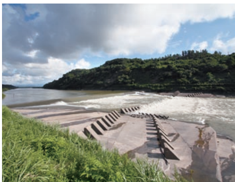
分水路河口部に近い第二床固（上）、急流による川底の洗掘を押さえている。信濃川本川に設 置された洗堰（下）は下流域に安定した水を供給するいわば「心臓弁」だ。
