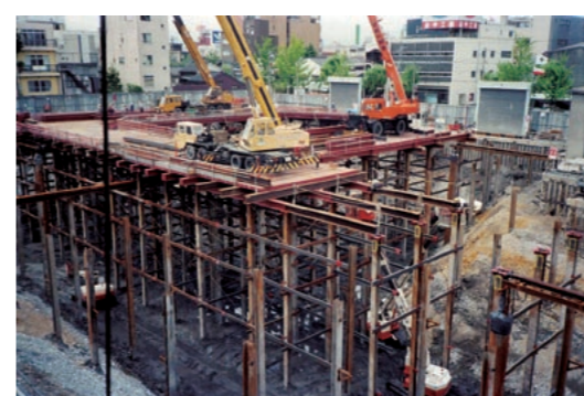
躯体の鉄骨工事。地下2階の掘削を成功させ、躯体が立ち上がっていった。(提供：佐藤工業(株))
