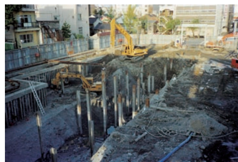
地下の掘削工事。周囲に連続壁の山留めを施工し、掘り下げている。残された市病院の地下室などの解体と並行して、地業が行われた。（提供：佐藤工業株）
