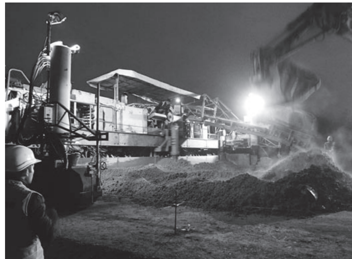
スリップフォーム式コンクリート舗設機械による施工
