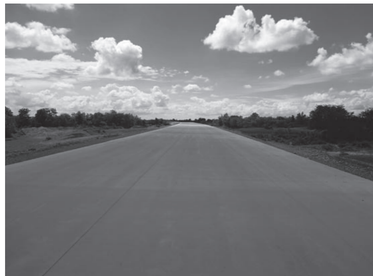
舗装後の状況
