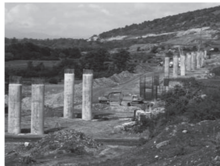
橋梁下部工施工状況
