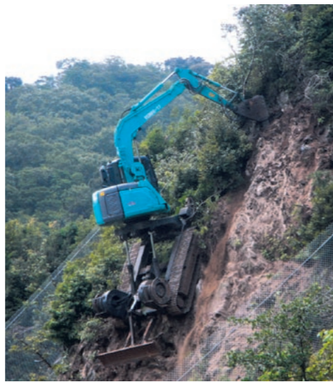
左/資機材の搬出入や土砂の運搬を担う1日50台にもなるダンプは主に整備中の路線を使う。一般道の交通に対する影響を最小限に留めている。 上/150項目にのぼる技術提案の1つ。ロッククライミングマシン。(提供: ㈱フジタ)
