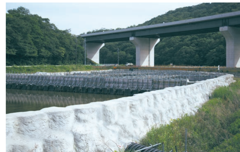
付近の農家の協力を得て田んぼに沈砂池を造成した。施工後の完全復旧を想定し、田地に影響を与えないよう遮水シートを敷き詰め、巨大な土嚢にモルタルを吹付けた壁で周囲を覆っている。
