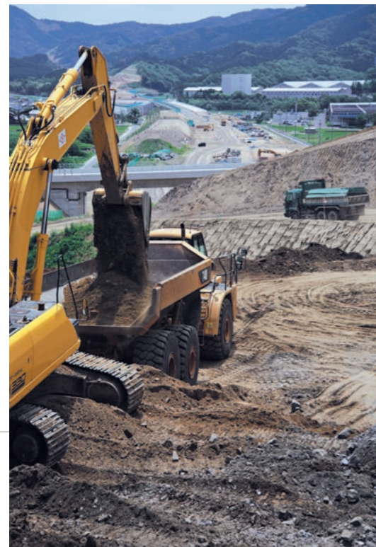
バックホウで削り取った土砂を25tの特殊ダンプで搬出する作業が黙々と進められる。周辺には中央に見えるランプ橋をはじめ、料金所のカルバートなど、構造物もほぼ完工している。
