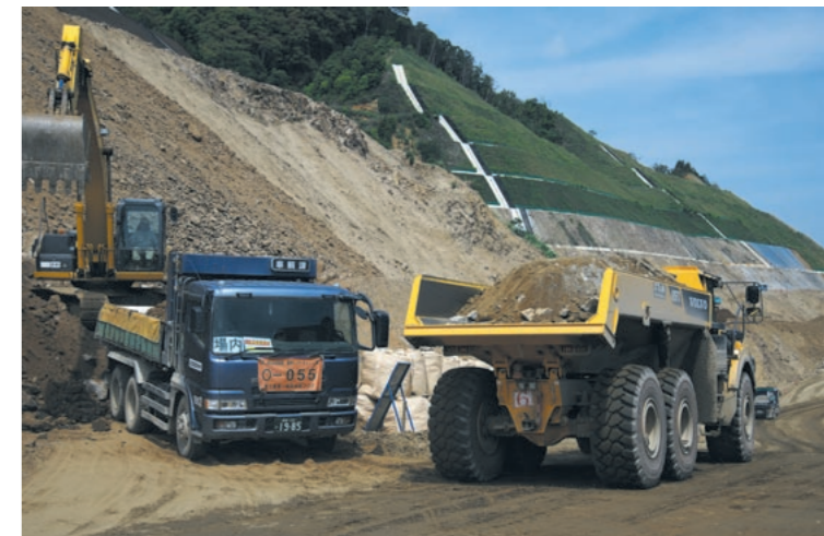
東京ドーム2杯分の切土230万㎡のうち80万㎡はフジタの現場で、その他は岡崎SAと大井野川橋の現場に向け搬出され建設資材として利用している。
