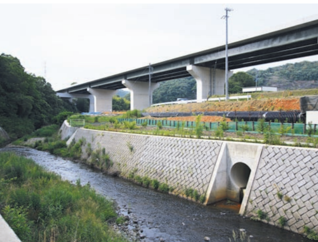
約500mにわたって南側に付け替えられた青木川。沈砂池で浄化された水が戻され、その清浄な流れは以前と変わることはない。
