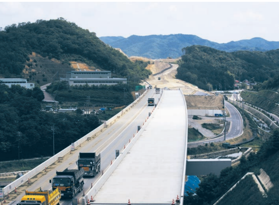
左/資機材の搬出入や土砂の運搬を担う1日50台にもなるダンプは主に整備中の路線を使う。一般道の交通に対する影響を最小限に留めている。 上/150項目にのぼる技術提案の1つ。ロッククライミングマシン。(提供: ㈱フジタ)
