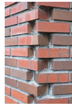
図は外壁の煉瓦積張り工法。鉄筋コンクリートの建物本体にしっかりと施工されている。写真は外壁の直角の部分で、厚みのある本物の煉瓦が積まれていることがよくわかる。
