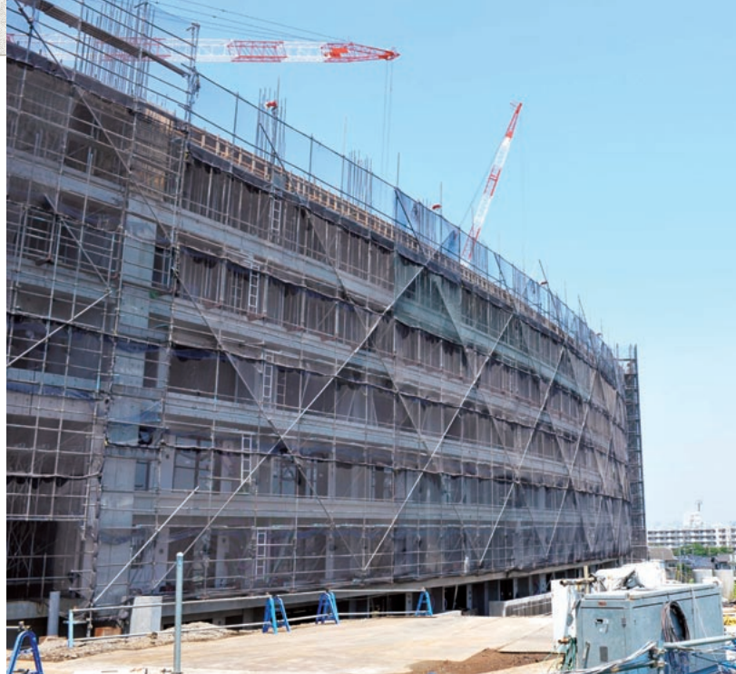
来年2月の引き渡しに向け現場は順調に進んでいる。横浜プリンスホテルの曲線をイメージした外観(K棟)も11月末には足場が取れる予定となっている。(提供:株長谷工コーポレーション)
