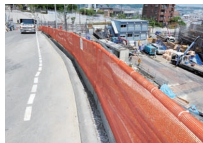
施工2社の作業エリアを明確にする色つきネット。オレンジ色が長谷工の区画。(提供：(株)長谷工コーポレーション)
