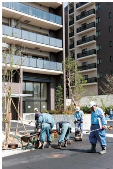
先行敷設した敷地内仮設道路の表層5cmを取り除き、本設道路として仕上げ中(1工区)。
