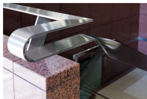
1階から地下に降りる階段の手摺。水平、垂直のステンレスのフラットバーが、うねりを描いて連なっていくデザインになっている。
