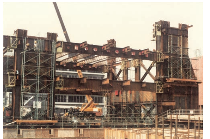
上／建物の基礎となる地中連続壁をつくるために用いられたフランス製のクラムシェルバケット。下／太い組柱と大梁。各階の大梁を6つの組柱と屋上・地下の壁梁という架構体に統合することで、内部に柱や壁のほとんどない大空間が実現された。 (上下提供：㈱篠田義男建築研究所)
