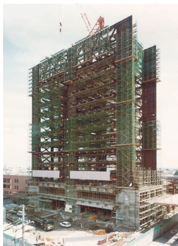
6本の組柱と屋上・地下の壁梁によるスーパーストラクチャー。バルコニーのPCパネル（※2）は、構造計画上、初期工程の時点で取り付ける必要があった。（提供：（株）篠田義男建築研究所）
