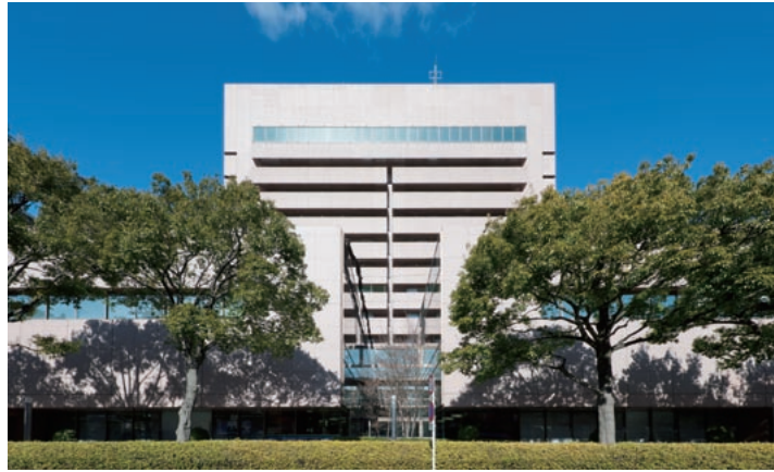
南側外観。街路の植込みと光庭の緑が連なっている。夏場はバルコニーにネットを張り蔓植物を繁茂させ、日射対策の「緑のカーテン」が建物を覆うという。
