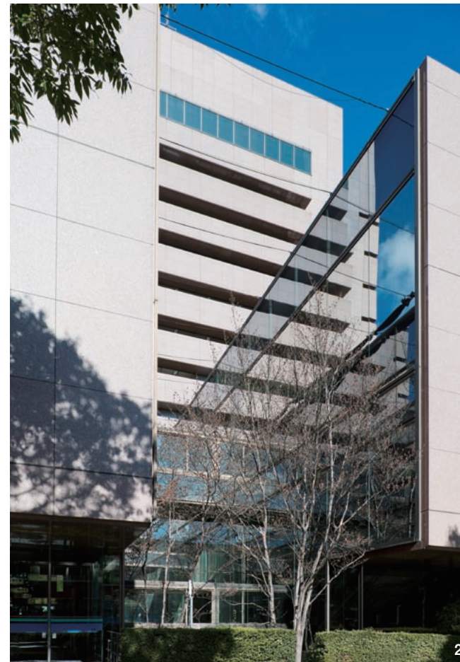
1 1階の光庭周辺。窓口のカウンターや記載台には、耐久性が高く、あたたか味のあるマコレ材が使われている。2 南側道路から低層部、高層部を見上げる。壁面の御影石はジェットバーナー仕上げでゴツゴツしているが、軒天井は本磨き仕上げでツルツルしている。3 光庭に架けられたブリッジ。光庭は1階からゆるやかに傾斜し、地下まで繋がっている。
