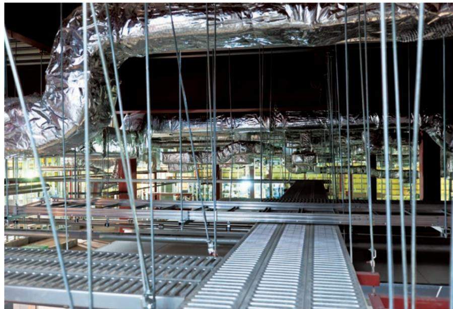
天井のダクトを縫うように張り巡らされたキャットウォーク。メンテナンスは地下通路にとどまらず、天井に至るまで徹底して行われる。(写真：山田新治郎)
