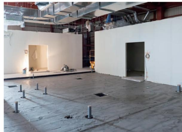
右／2階内観、工場部分。臭気対策のために、すべての排水箇所にはトラップが設けられている。(写真：山田新治郎)
