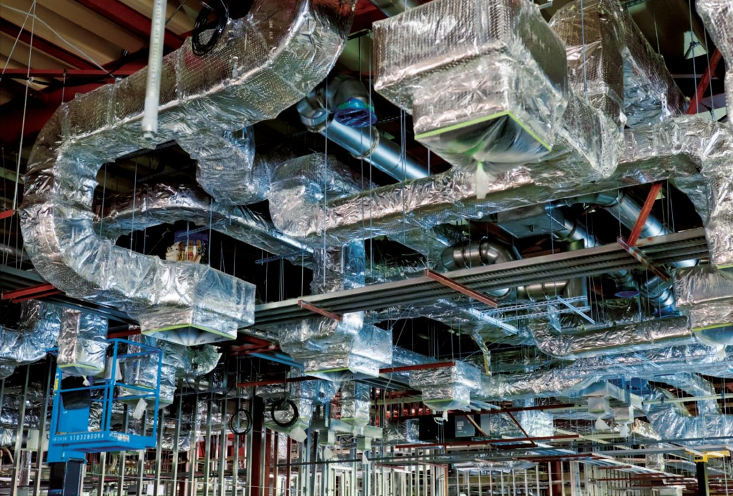
1階工場天井部分。ダクトの先端が養生されている様子。設備機器が取り付けられるまでは作業中の埃がはまらないように配慮されている。(写真: 山田新治郎)
