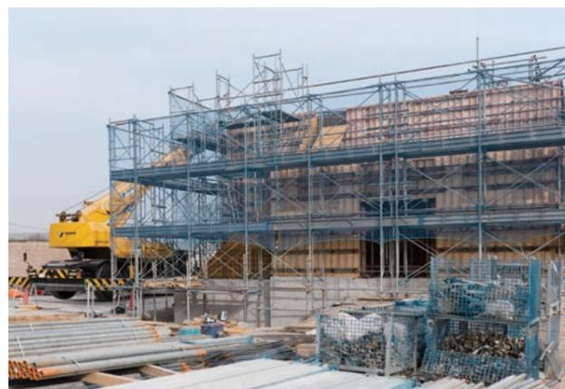
敷地の奥につくられた排水処理施設。工場で排出された水をここに一度貯水し、濾過するための施設。(写真：山田新治郎)
