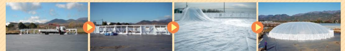
小型移動式クレーン使用 フレーム施工完了 フィルム取り付け中 施工完了
