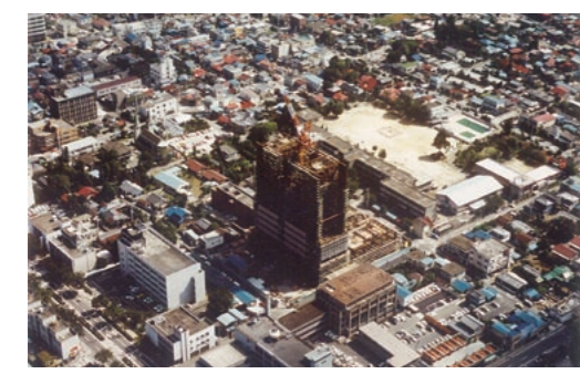
施工中の様子。市庁舎には議会棟が隣接しており、渡り廊下で結ばれている。写真右下（西）の建物が議会棟。(提供：榎坂倉建築研究所)
