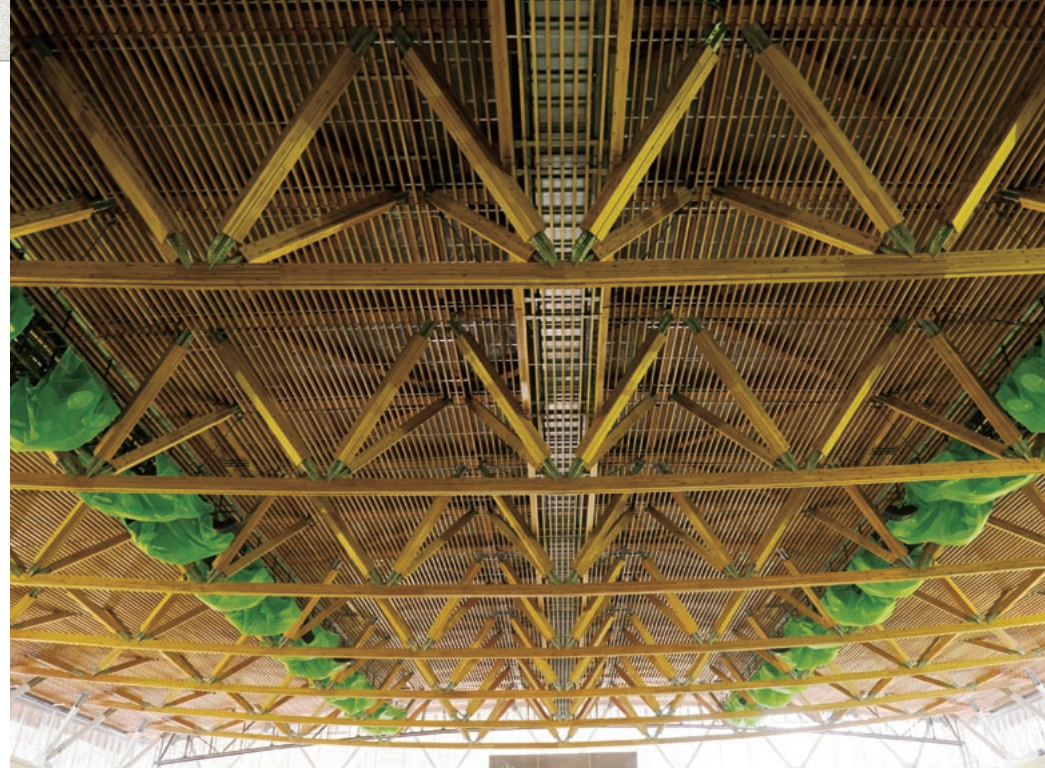
ハイブリッドトラスの上弦、下弦、梁を受けるポイントは112カ所。ミリ単位で調整しながら施工した。約50×70mの大屋根をがっちり支えている。中央部には点検用のキャットウォークが縦貫する。
