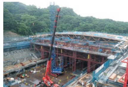
上／作業ベースとなる可動式足場はレール上を内蔵モーターでスライドする。上下の調整もセンチ単位で可能だ。(提供：西松建設(株)) 左／檜材の集積材で鉄骨をサンドイッチした部材によるハイブリッドトラス。一部を地上で組み上げ、クレーンで揚重しジャッキで仮受けしながら施工した。(提供：西松建設(株))
