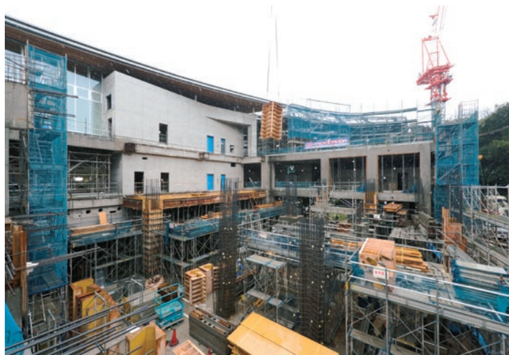
現場は森に囲まれた狭隘な敷地。着工当時から早期完工を目指し、複数の工程が錯綜することも少なくなかった。最も手前のエントランス部分は最後の施工となった。
