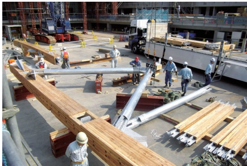
上／作業ベースとなる可動式足場はレール上を内蔵モーターでスライドする。上下の調整もセンチ単位で可能だ。(提供：西松建設(株)) 左／檜材の集積材で鉄骨をサンドイッチした部材によるハイブリッドトラス。一部を地上で組み上げ、クレーンで揚重しジャッキで仮受けしながら施工した。(提供：西松建設(株))
