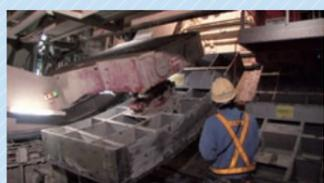
一次覆工コンクリート打設設備では内型枠が組み立てられ、コンクリートが打設される。
