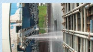
トンネル掘削面では、掘削面に添加剤を加え、土砂を塑性流動化し、切羽を安定させている。
