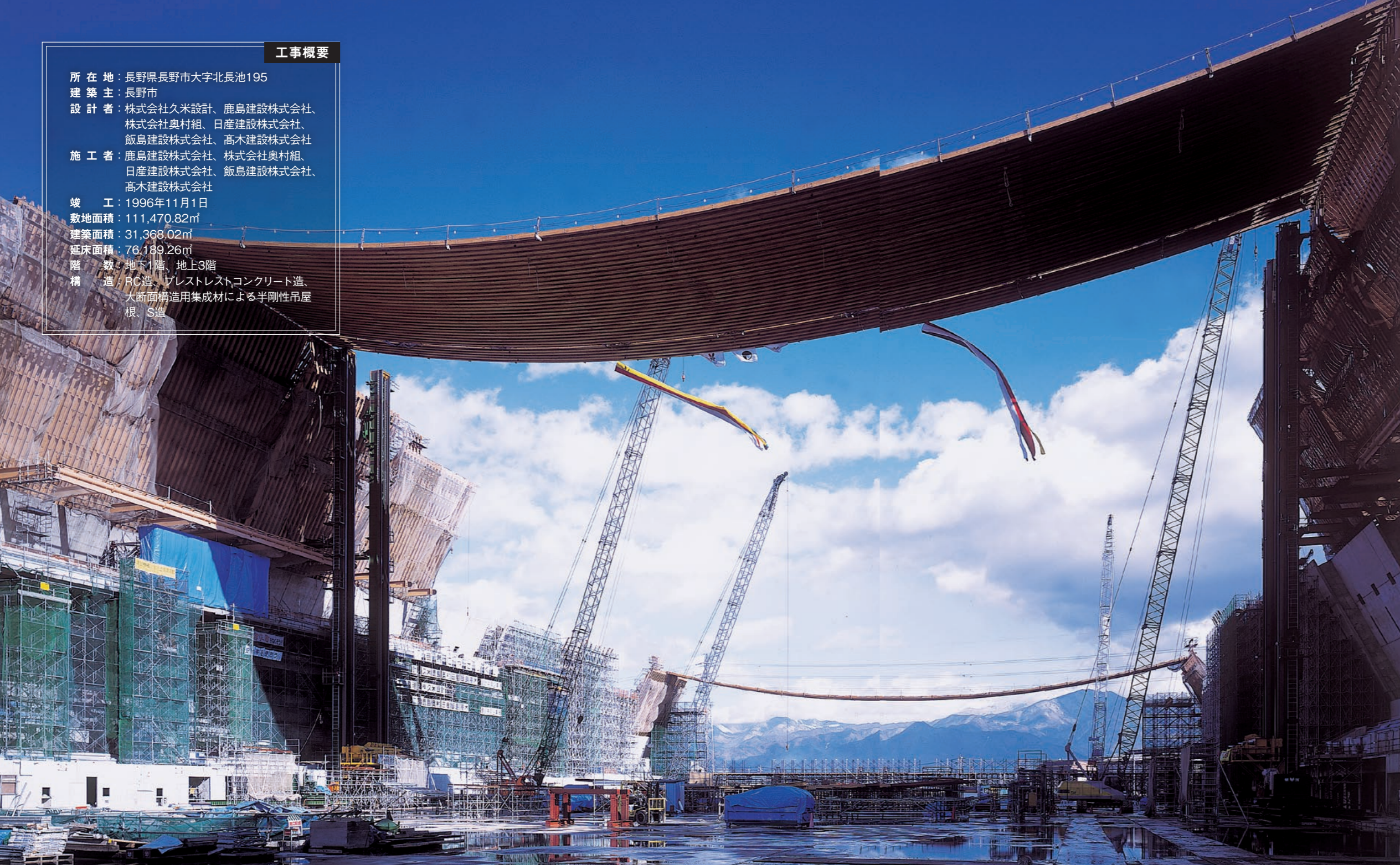
高所作業の低減・工期短縮を目的に検討・開発された吊り屋根のリフトアップ工法の様子。約7,000本の信州カラマツが次々に吊り上げられていく。
