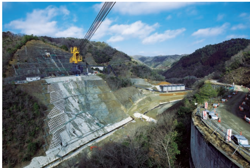
上/右岸側（写真手前）天端付近にコンクリートプラントを建設。左/右岸（写真奥）から左岸にむけケーブルクレーンを渡しコンクリートを運搬、打設する。
