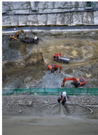
取材時には河床部の発破、基礎掘削の仕上げが行われていた。4月からは本格的な堤体の構築、コンクリートの打設が始まる。
