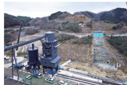
上/右岸側（写真手前）天端付近にコンクリートプラントを建設。左/右岸（写真奥）から左岸にむけケーブルクレーンを渡しコンクリートを運搬、打設する。
