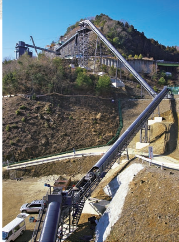
県内で調達した良質の骨材を50mの急傾斜ベルトコンベアで天端付近のコンクリート製造設備まで一挙に運搬する。
