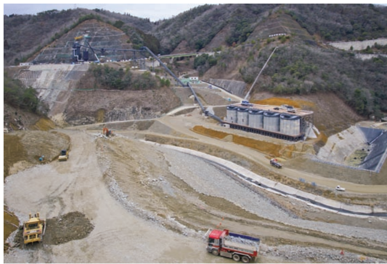
写真右側に見えるのが工事用貯水池。鞍居川の水流を貯留し、左手のコンクリート製造設備の練混水、養生水等の工事用水として供給する。
