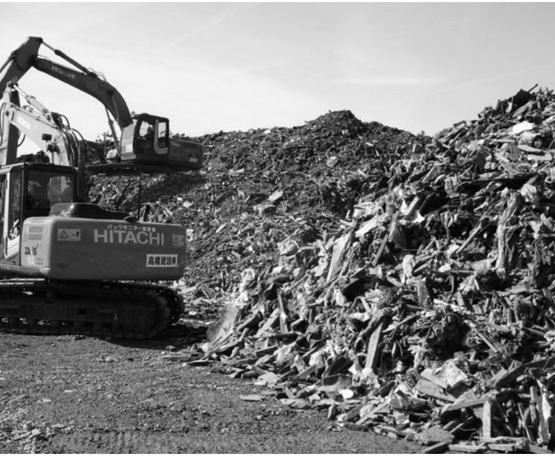
重機を使って山積みされたがれきを分別する（宮城県内）。
