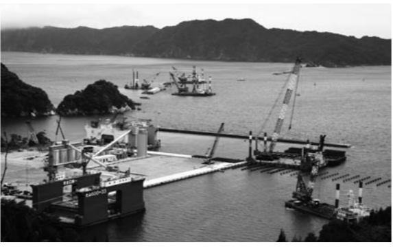
釜石港で進む湾口防波堤復旧工事。
