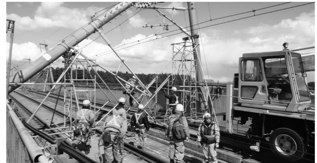
東北新幹線復旧工事は急ピッチで進められた。
