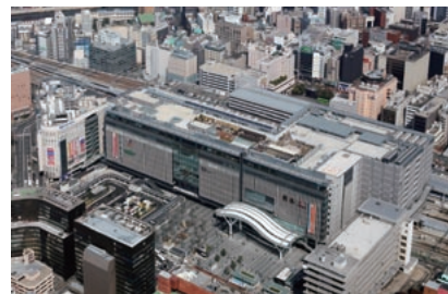
写真左側（北側）が旧駅ビルの敷地。新駅ビルは南側と線路上空部を増設したL字型の構造となった。（提供：九州旅客鉄道株）
