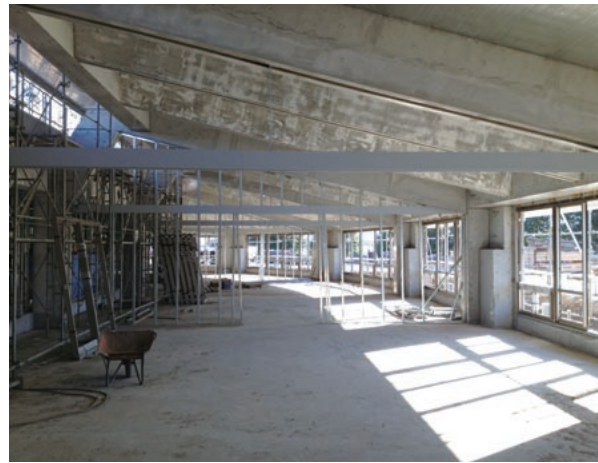
内部の保育室からは園全体を見渡すことができる曲面的な構造。季節の変化、吹き抜ける風を体感できる。(提供：(株)竹中工務店)
