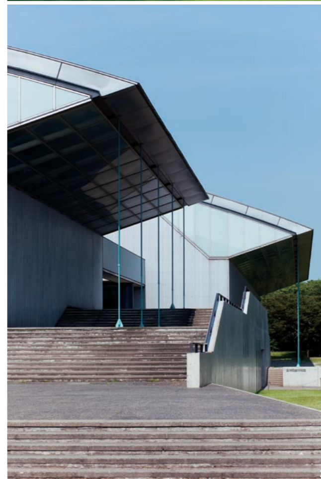
1 南面外観。南側のグラウンドより見る。2 観客席のある2階への動線。キャンチトラスのバックステイが外部に現れている。3 1階のラウンジ。メインアリーナとサブアリーナの間であり、中庭に面している。
