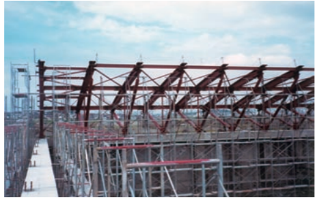
キャンチトラスが先に組み上げられ、後に張弦梁が嵌め込まれる工程。（提供：酒田市）
