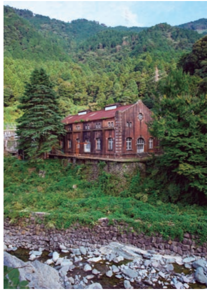
端出場水力発電所
