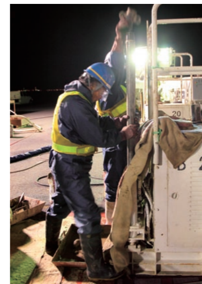
モルタルの注入を行なっている現場。設置された白い機械が注入管リフト装置。注入が進むに従い、管を引き上げる。
