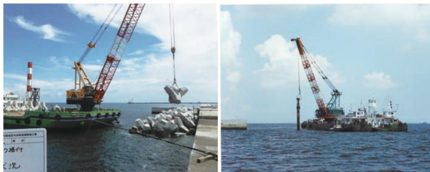
船上の起重機に吊り下げられた重錘を捨石に繰り返し落下させて基礎マウンドの上面を平坦にする「マリンプレス工法」を採用(右)。波消ブロックを施工し耐波性能を確保する(左)。
