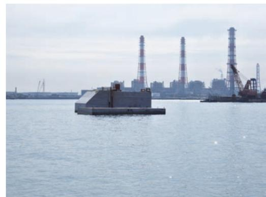
台形のブロックが南防波堤の先端部。その手前の海面に仮置きされたケーソンの上部が覗く。身を沈めて中央防波堤に曳航される時を待っている。(写真：西山芳一)
