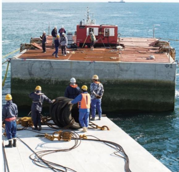
センチ単位の精度が求められるケーソンの曳航、据付け。荒れる鹿島灘の海象を読み、風を待って間隙を突くように施工に望む。
