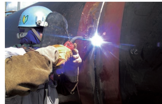
五十嵐所長は「鋼管は品質と溶接が命」と語る。水路に用いた鋼管は全数材料検査とX線検査を実施、最高水準の品質と精度を追求した。(提供：西松建設(株))
