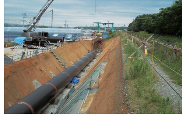
永きに渡り渥美半島に水を送り続けてきた「豊川用水」。堤に沿うように新たな併設水路が施工された。(提供：西松建設(株))
