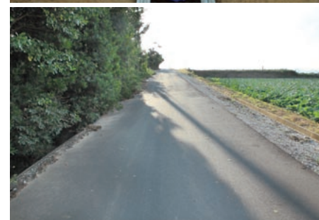
開削により設置された新しい鋼管製の水路(左上)。(提供：西松建設(株)) 復元後の道路(左下)。施工後は掘削の際に仮置きしておいた土を元に戻し復元する。畑、農道ともに原状復旧が原則だ。
