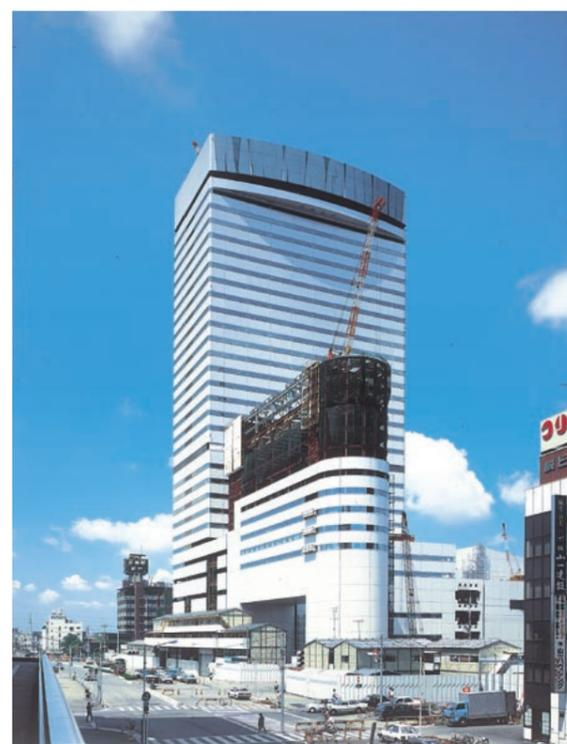
施工中の様子。ホテル棟の上層は仕上げ前で鉄骨が露出している。鉄骨は著しく電波障害を引き起こすため、工事中に鉄骨が露出する面積には制限があった。（提供：GA photographers）
