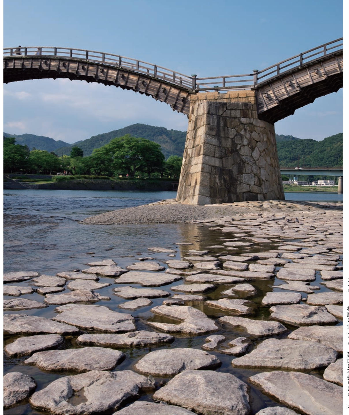
河床の床固め 河床掘削を防ぐため、石張りが施されている。昭和二十五年のキンヤ台風による流失後、石造橋脚は、コンクリート橋脚に変えられ、表面は石張りになった。
