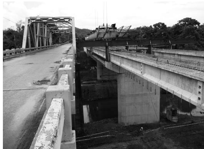
ラトンガ橋の架設状況
