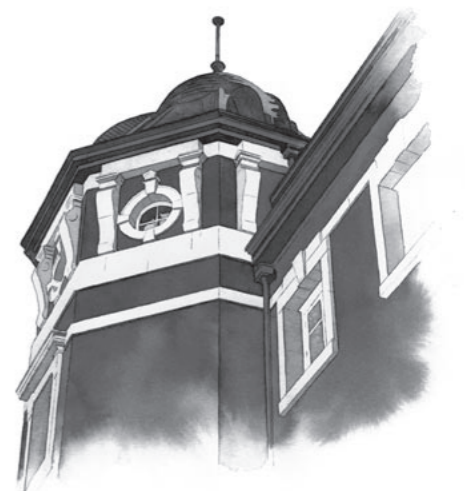
曲線的な形の「持ち送り」など、窓周りには複雑な部材が多い
