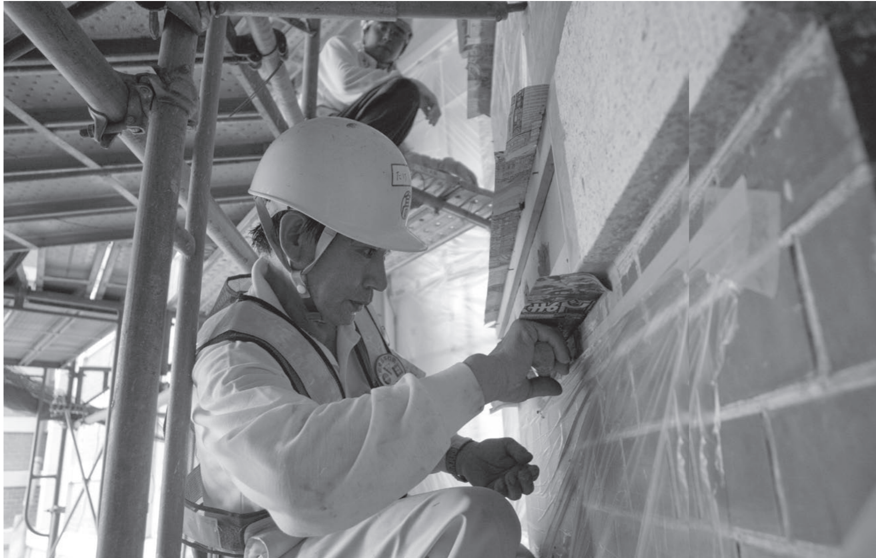
竹下の仕事ぶりを、若手の藤本が見つめる。今回の工事を契機として顧みられ、次世代に伝えられた技術は数多い。
