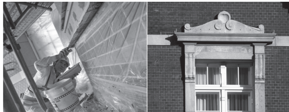
右/日本建築の「破風(はふ)」にあたる「ペディメント」。古代ギリシャ神殿などに見られる建築様式の一つで、丸の内駅舎では窓の上の装飾に用いられている。 左/木枠を使い、擬石を狂いなく整形していく。鏝にも、広い部分を塗るものや表面を仕上げるものなど多くの種類がある。
