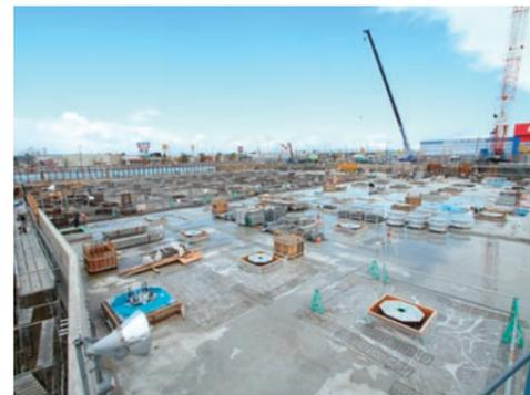
施工中の現場全景。免震装置の設置が進められている。
