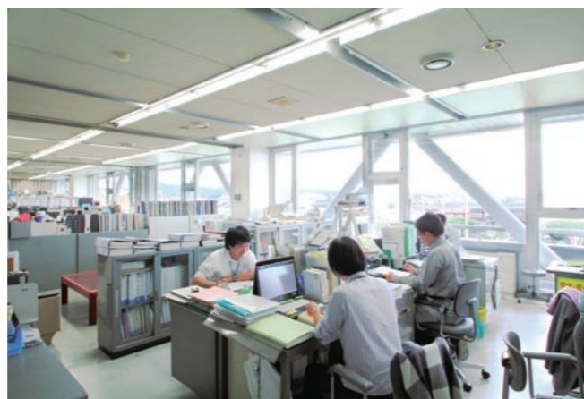
岩沼市庁舎の執務室。大きな開口部の耐震性を上げるために、バルコニーにアルミブレースを設置。居ながら施工が行われた。
