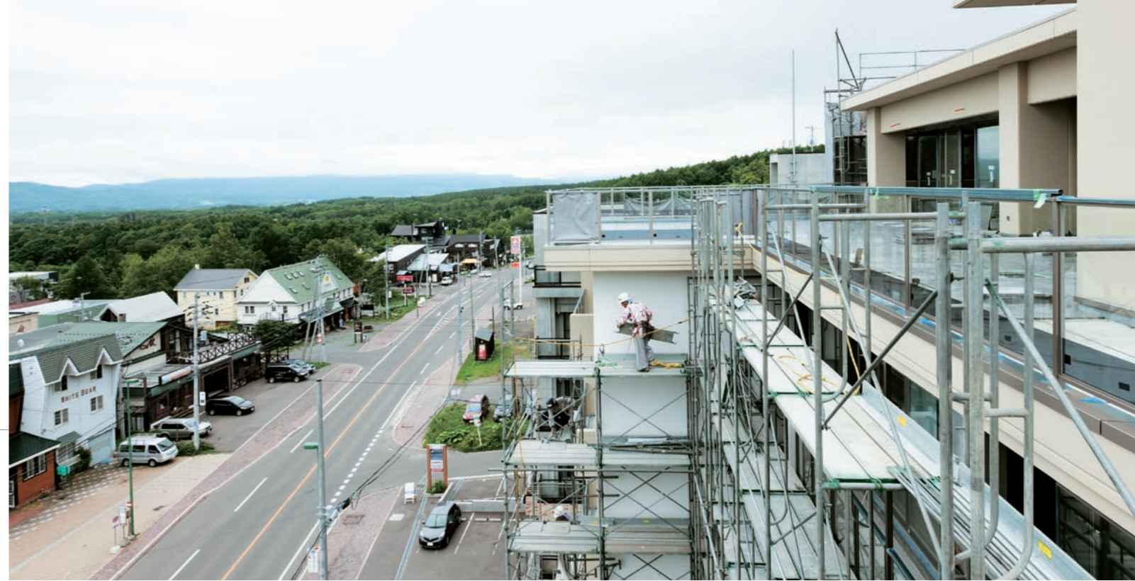
2012年8月、建設途中の屋上から見える景色。冬には常時2mほどの雪に覆われる。
