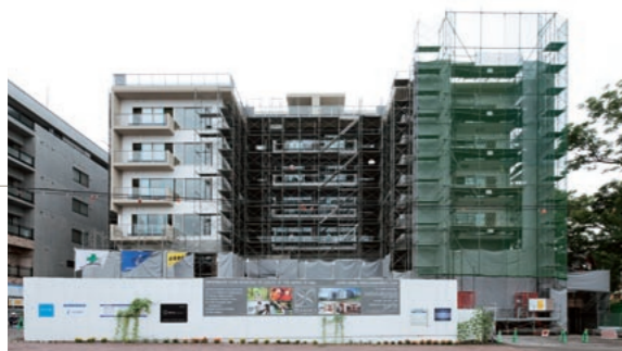
建物全景。外壁の色や素材を承認されるまでに半年掛かったという。
