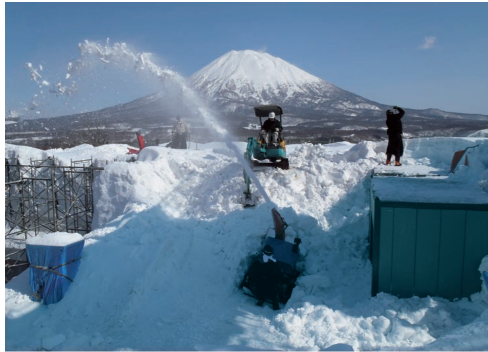
スキーシーズンが終わり、再び現場を動かすためには大量に除雪する必要があった。1シーズンの累積積雪は、11mにもなる。奥に羊蹄山が見える。（提供：岩田地崎建設（株））
