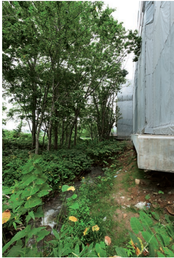
右/造成工事をしている時に、出てきた転石。そのため基礎工事の日程が、工程どおりに進まないことも多かった(提供:岩田地崎建設(株))。左/敷地のすぐ横を流れる冷水川。春先には雪解け水により、川幅が2mほど広がる。
