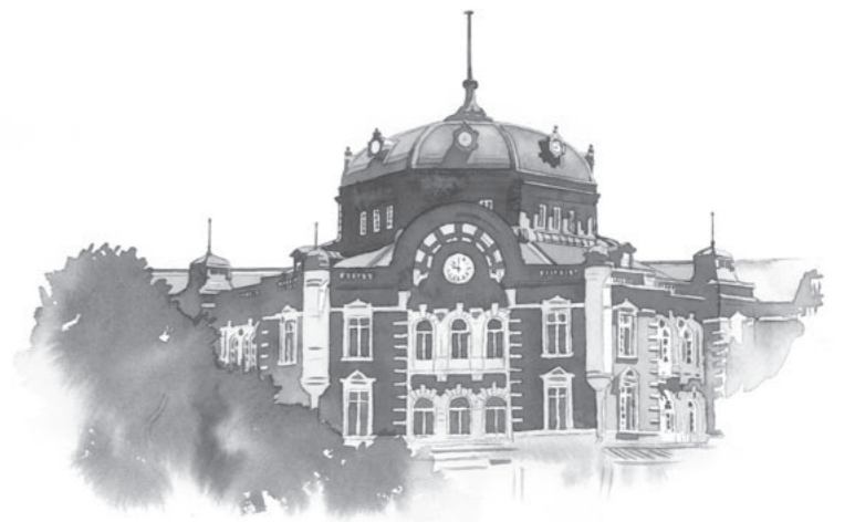
よみがえった東京駅のドーム屋根
