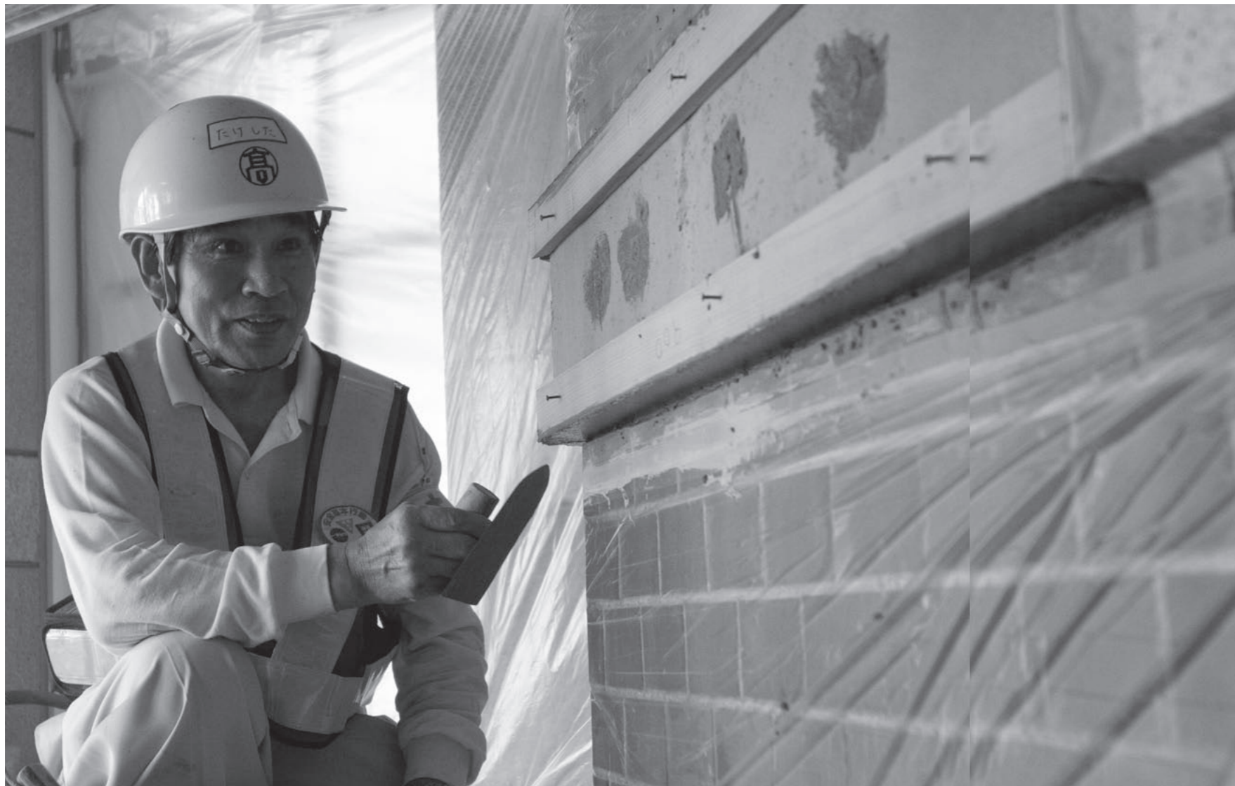
丸の内駅舎の装飾「擬石」を施工する。擬石は花崗岩や大理石などの天然の石に似せて作られた建材で、「人造石」とも呼ばれる。近年は用いられる機会が少ない。
