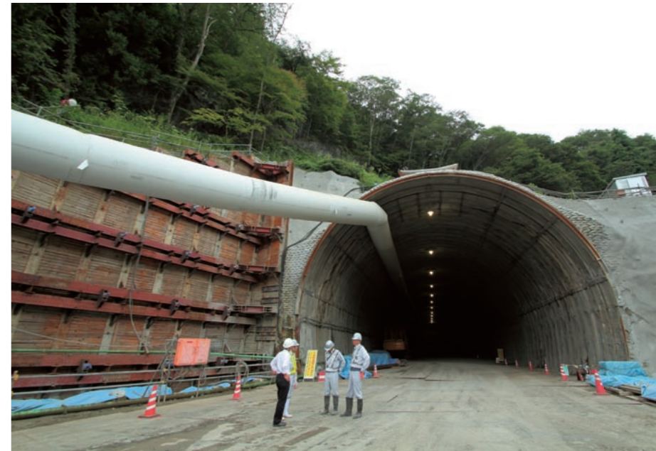
水平ボーリングなどの事前調査により、現場は凝灰質泥岩の軟弱な地山であることが判明。15mもの大断面のトンネルを「支持しながら掘削」する多くの補助工法が採用された。
