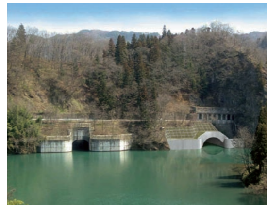
左がすでに完成している1本目のトンネル、右が第2河川トンネルの完成予想だ。(提供：長野県)
