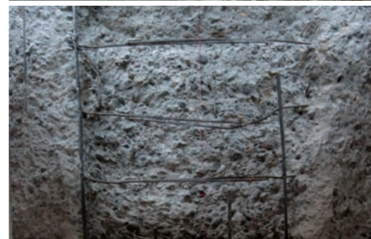
上/昭和の施工時に地盤を強化するために打設された松杭。例えばこの松杭が打たれているのは垂直方向なのか、それとも斜杭なのか？撤去の際にも「想像力」と正確な検証が要求された。
