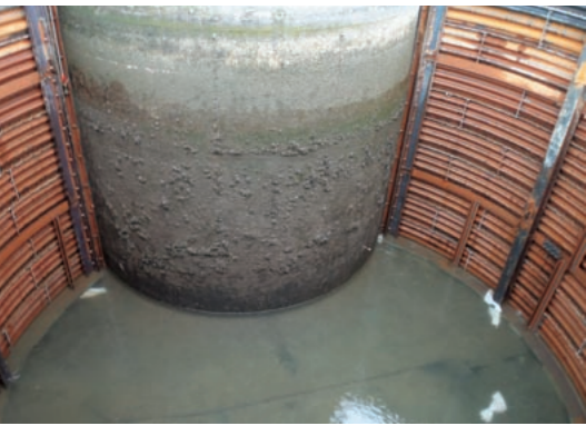
堰柱の基礎部周辺を鋼矢板で締め切り内側の川水を排出、ドライ状態にして補修した。
