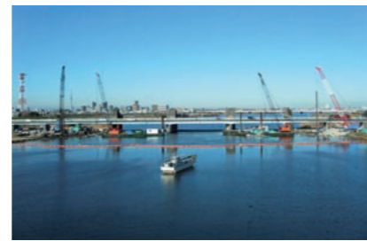
河川工事は渇水期の11月から5月に限定される。少しの遅延が大幅な工期延長に繋がりがかねないため、日々の工程厳守が最重要課題だ。
