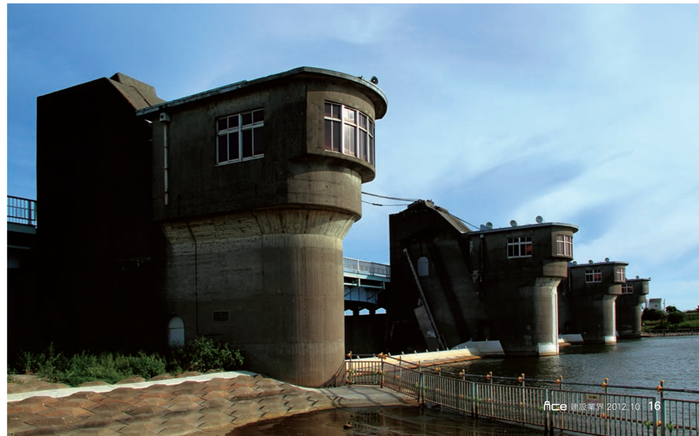
行徳可動堰全景。鋼製ローリングゲート（純径間30m×門高5m×3門）が昭和32年に設置された。（写真：中原一隆）
